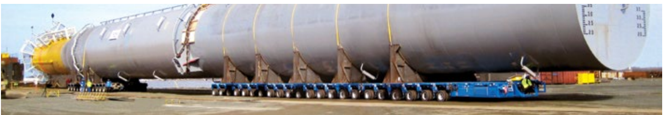
PST/SL-E im Einsatz
